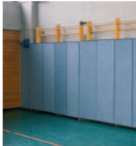
Verfahrbarer Prallschutz als Nachrüstlösung
