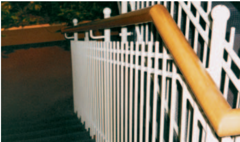
Rutschverhinderer und durchgängiger Handlauf
