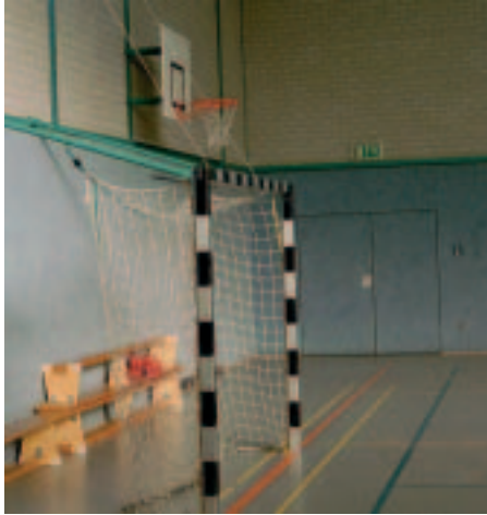
Sporthalle mit Prallschutz bis zu einer Höhe von 2 m
