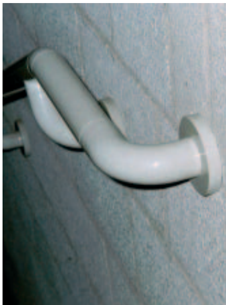
Handlaufende in Richtung Wand
