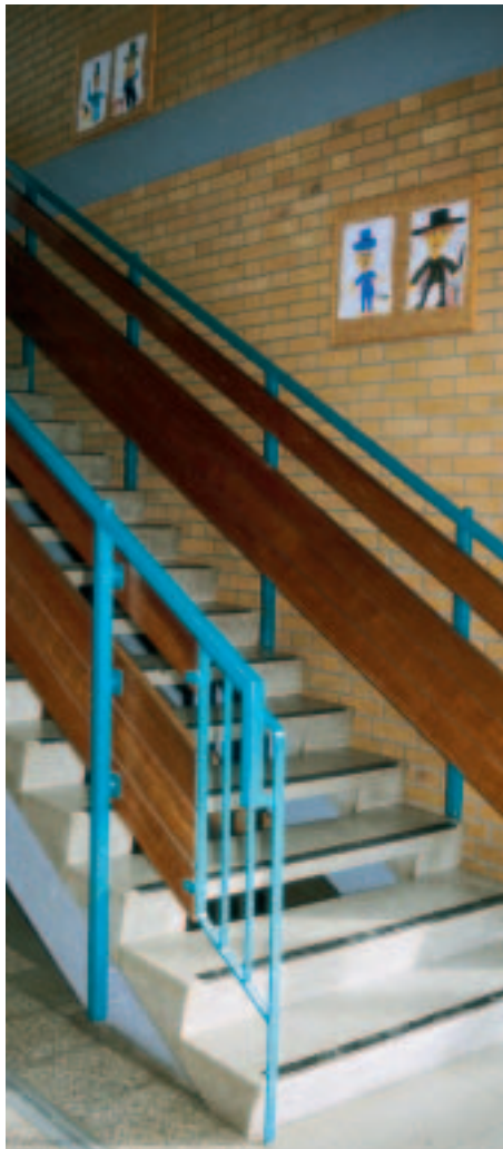
Stufenvorderkante sichtbar gemacht
