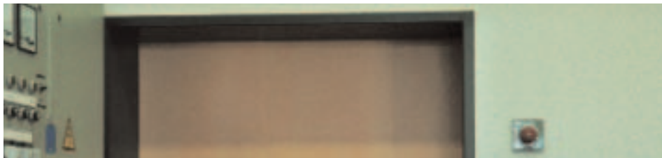
Not-Aus-Taster neben einer Tür mit Schlüsselschalterfunktion
